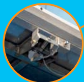
Détecteur sur le nez de la plate-forme
